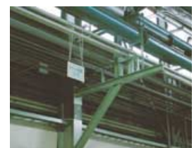
本社工場蒸気メイン配管の補強
