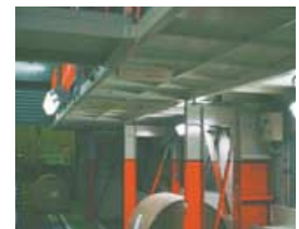
本社工場制御盤用架台の補強
