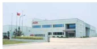
昆山愛克樹脂有限公司全景
